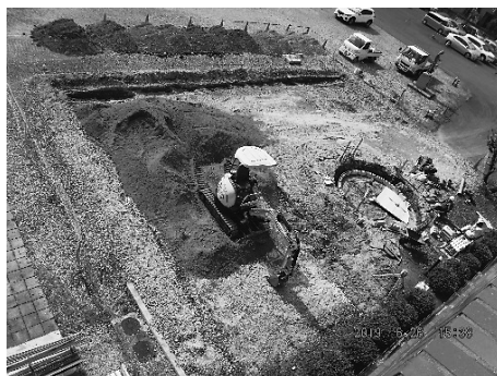
写真10 業者による工事着工
